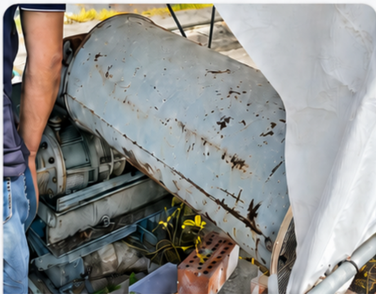
B 改造前：原罗茨机现场
